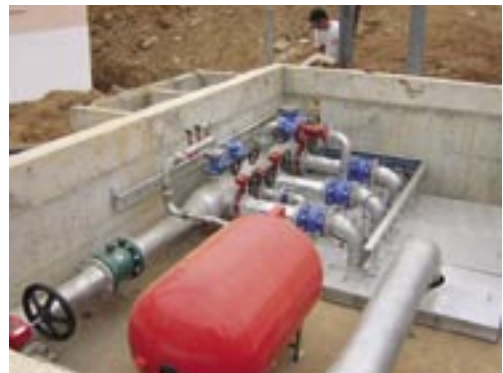
Figura 2.4-2 Estação de bombagem – Construção de Campo Real
