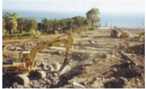
Figura 7 Imagem da fase de construção do campo de golfe em Gomera, Canárias
