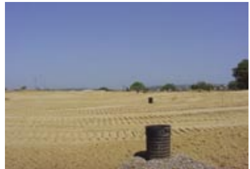
Figura 3.3-21 Sumidouros nos pontos baixos
