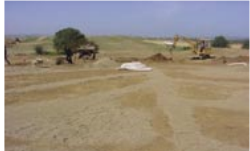
Figura 3.3-13 Drenagem a ser construída Note-se o enchimento com brita até ao nível da sub-base
