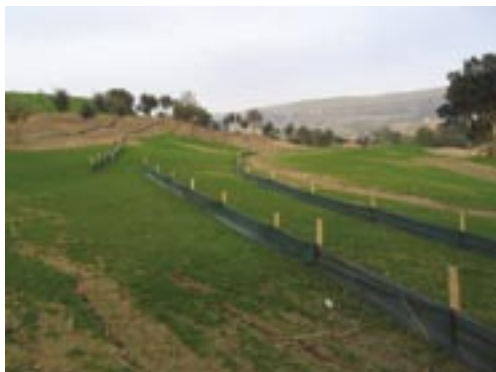
Figura 2.5-4 Barreiras de sedimentação - resultados Construção de Campo Real
