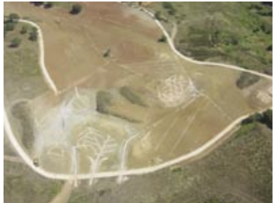
Figura 2.4-3 Sistema de drenagem – Construção de Campo Real
