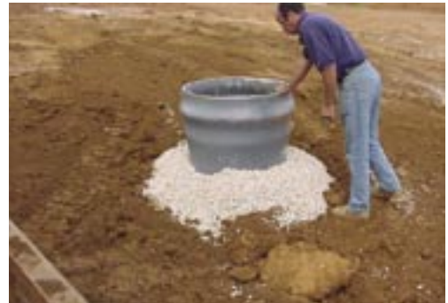
Figura 3.3-20 Inspeção a sumidouro de 80 cm de diâmetro após instalação
