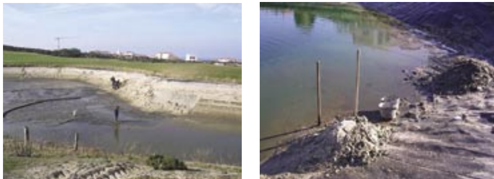
Figuras 4.2-39 e 4.2-40 – Aspectos da remoção manual de lamas.
