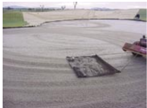
Figura 3.3-8 Acabamento final de um green com drag-mat
