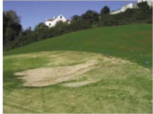
Figura 2.5-2 Sedimentação num green – construção de Campo Real
