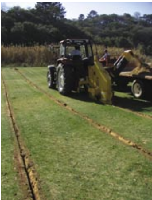
Figura 3.4-4 Trabalhos de drenagem durante a fase de maturação – Campo Real
