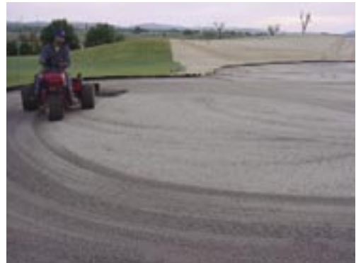
Figura 3.3-7 Acabamento final de um green com máquina de bunkers
