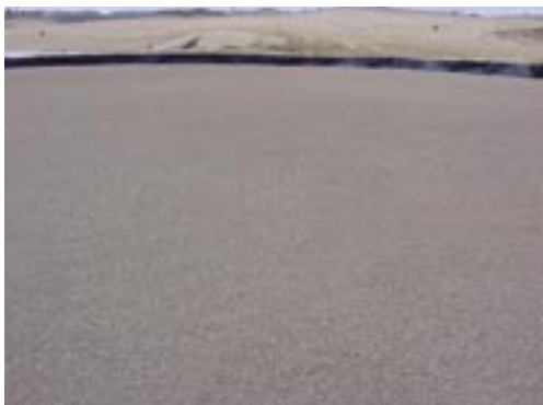
Figura 3.3-4 Camada de gravilha espalhada num green
