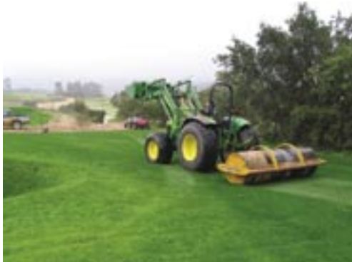
Figura 3.4-5 Rolar para consolidar e regularizar a superfície Campo Real
