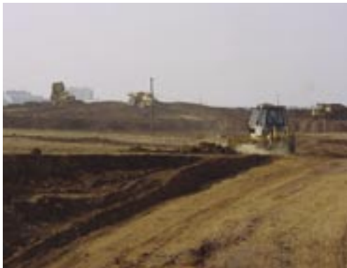
Figura 3.3-19 Máquinas pesadas a executar a movimentação de terras
