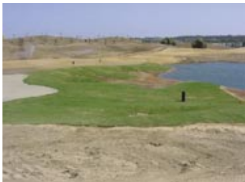
Figura 3.3-29 Complexos de bunkers com relva em tapete plantada e drenagem instalada
