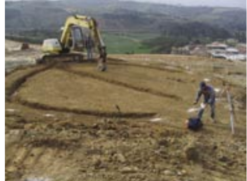
Figura 2.4-4 Drenagem de tees – Construção de Campo Real
