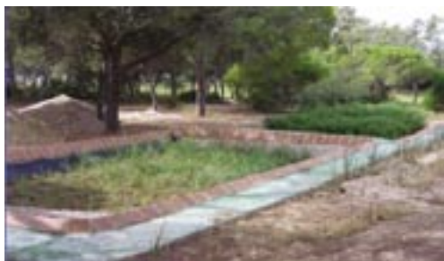
Figura 2.7-1 Fito ETAR associada a instalações de manutenção do campo de golfe (Oceânico Old Course, Vilamoura, 2005)
