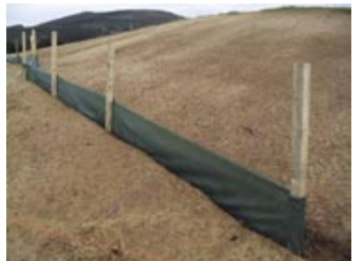
Figura 2.5-3 Barreiras de sedimentação – construção de Campo Real
