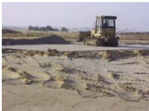
Figura 3.3-6 Máquina a espalhar e compactar root-zone num green
