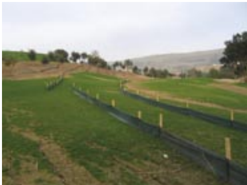
Figura 3.4-3 Barreiras de dissipação de energia e retenção de sólidos, utilizadas na prevenção e controlo de erosão – Campo Real
