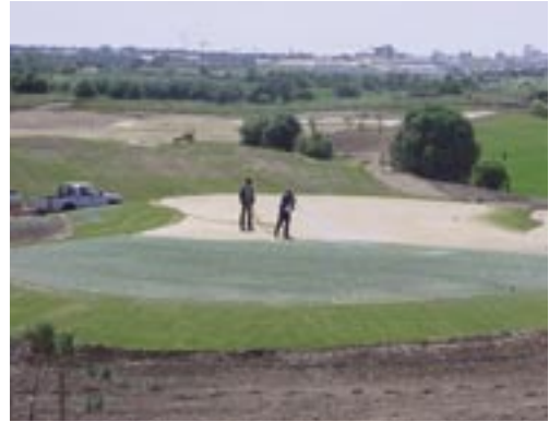
Figura 3.3-16 Hidroplantação de um tee com bermuda híbrida
