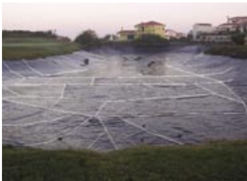
Figura 4.2-17 Sublinhado das soldaduras da tela de revestimento de um lago artificial.
