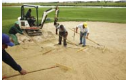
Figura 3.3-31 Transporte e espalhamento de areia
