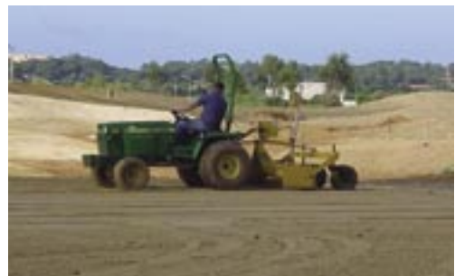
Figura 3.3-14 Pá niveladora orientada por laser a realizar o acabamento da root-zone num tee
