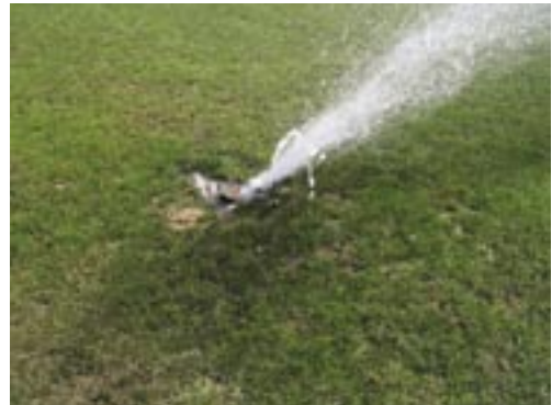
Figura 2.3.2-4 Exemplo de um aspersor que está a regar incorrectamente por estar mal nivelado.
