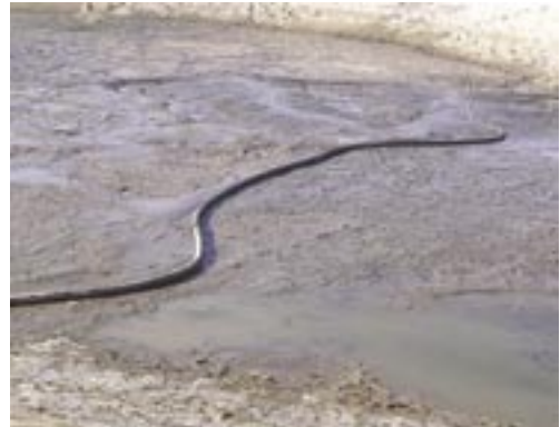
Figura 4.2-6 Lama acumulada em lago artificial.
