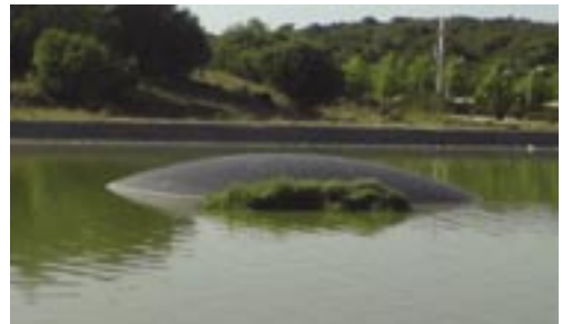
Figura 4.2-16 Formação de bolsas de gás sob a tela de lago artificial
